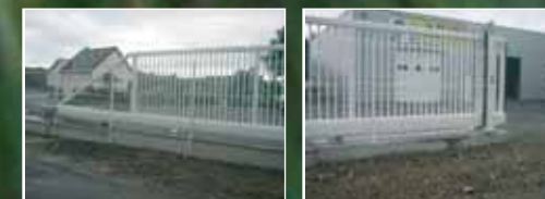
Pose et scellement
